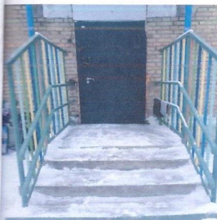
ФОТО № 17 вход выход в здание, вход в группу № 6
