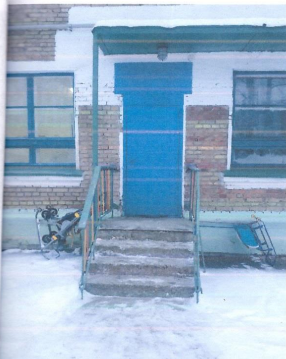
ФОТО № 13 вход выход в здание
