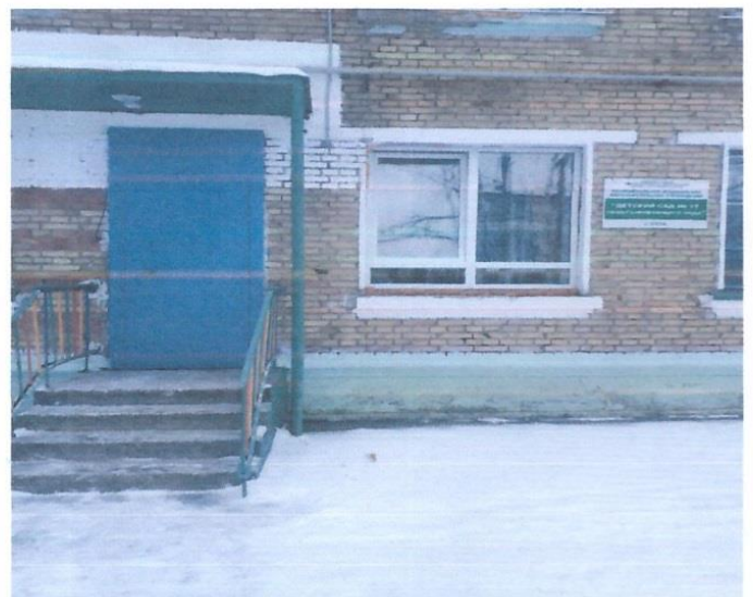
ФОТО № 12 вход выход в здание(центральный вход)
