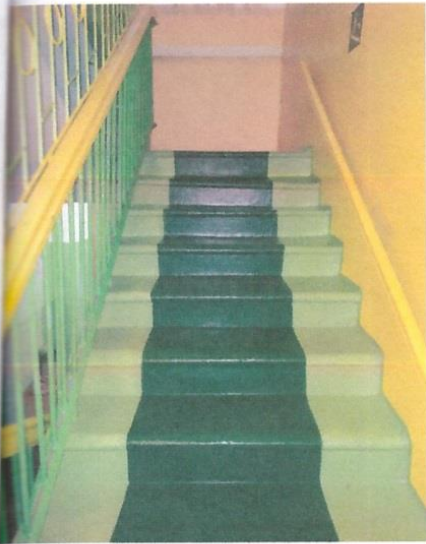
ФОТО 36 лестница внутри здания
