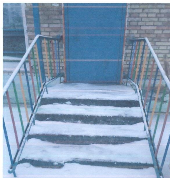
ФОТО № 16 вход выход в здание
