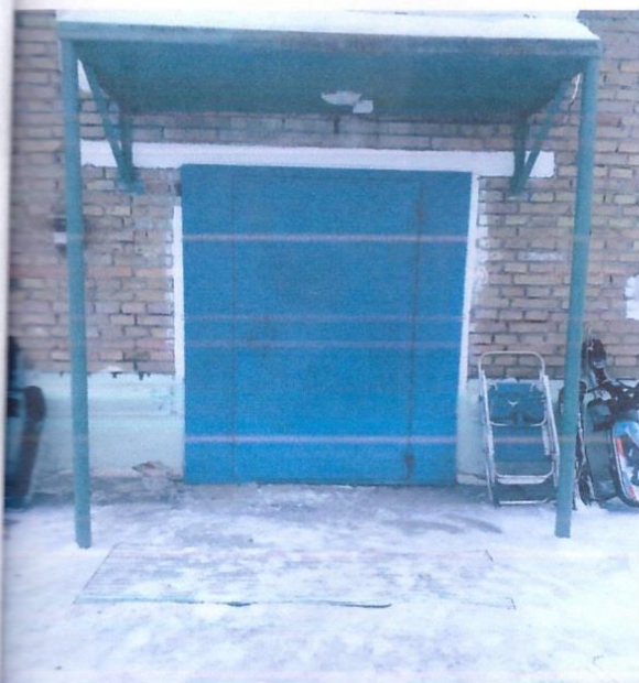
ФОТО № 15 вход выход в здание
