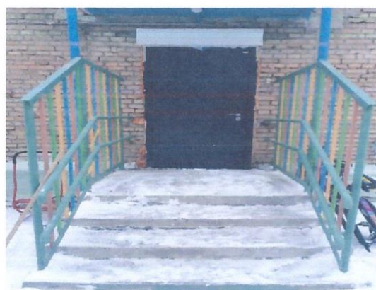
ФОТО № 18 вход выход в здание, вход в группу №1
