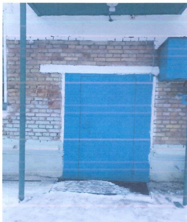
ФОТО № 14 вход выход в здание
